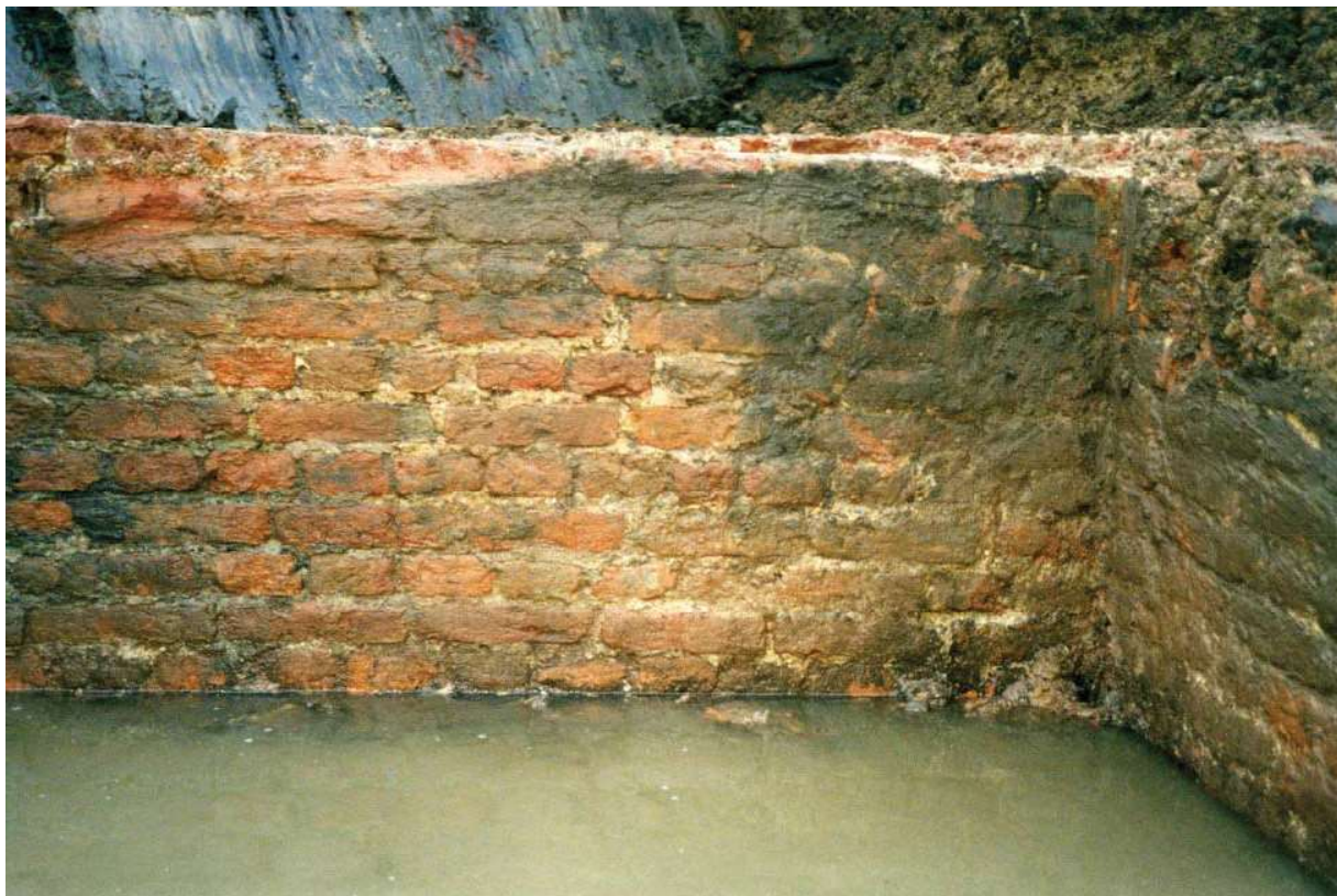
Afb. 16. Binnenzijde van de oostelijke kasteelmuur tussen pijlers 1 en 2, metselwerk in 'staand verband'. Foto auteur.
